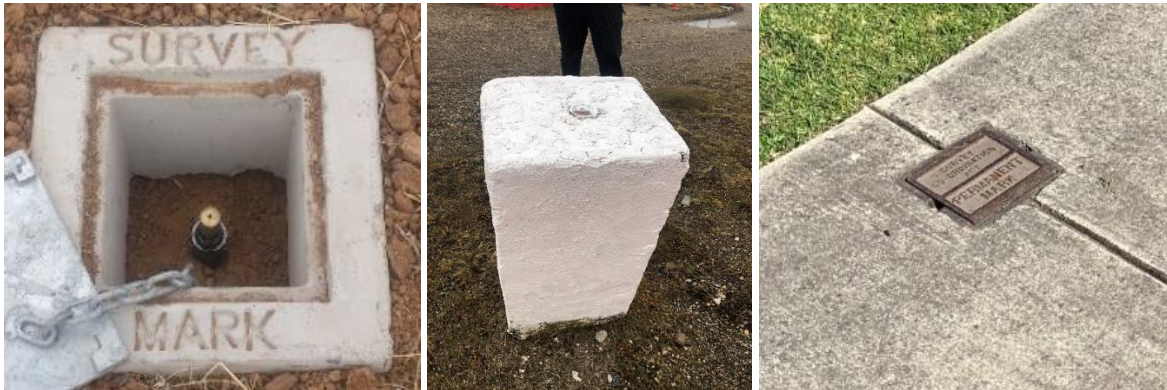
Ilustración 6 Tipo 1, 2 y 3 de monumentación de puntos permanentes. Fuente: (Surveyor General Victoria et al., 2022b), Centro USC y (Surveyor General Victoria et al., 2022a)
